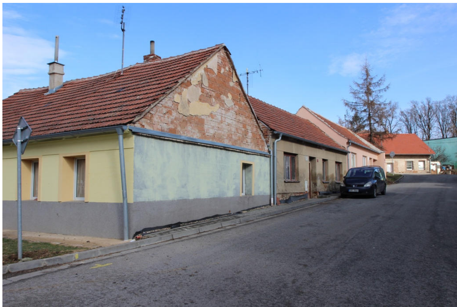
Pohled na domy před úpravou z ulice Tikovická
